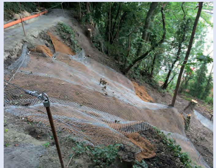
Teilbereiche der Murbahn wurden mit Stahldrahtnetzen gegen Erosion gesichert
