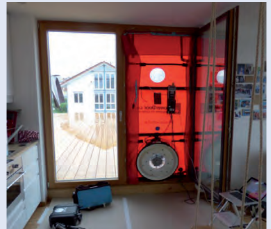
Eingebautes Blower-Door-Gerät in der Dachterrassentür
