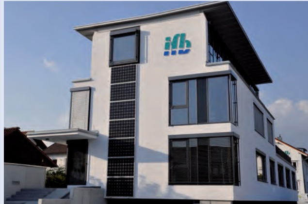
Außenansicht des neuen Bürogebäudes
