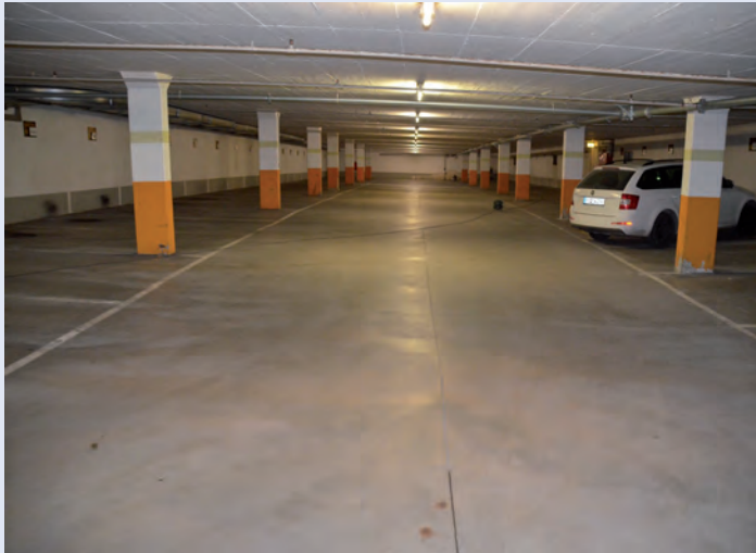
Bild 1: Übersichtsfoto Tiefgarage, Teilbereich
