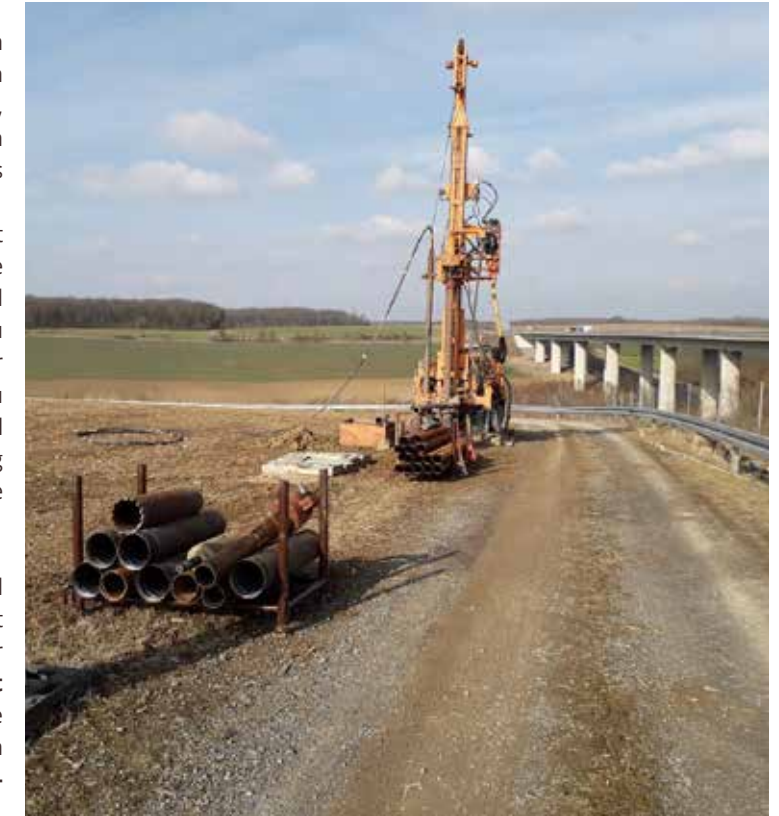
Bodenprobenahme entlang der Erdkabeltrasse
