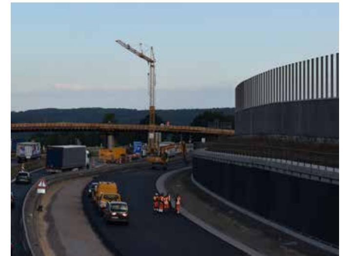
Baustelle auf der Autobahn A 3 bei Regensburg
